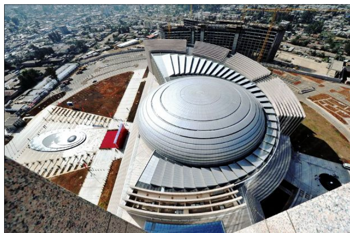
Addis Abeba - La nuova sede dell'Unione Africana finita di costruire nel gennaio scorso da 1200 operai cinesi ed etiopi
